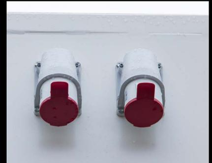
Die Verbindung zu den Containern erfolgt mit genormten CEE-Steckern (32A/400 V/5-polig)
